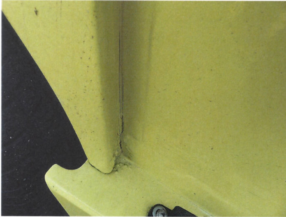
Bild 25 Kleinere Mängel Dichtnaht gerissen
